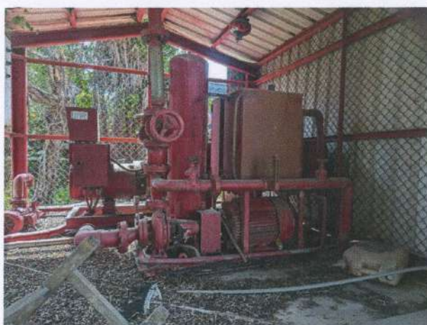
建物現況照(内部)
