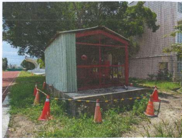
建物現況照(外部)
