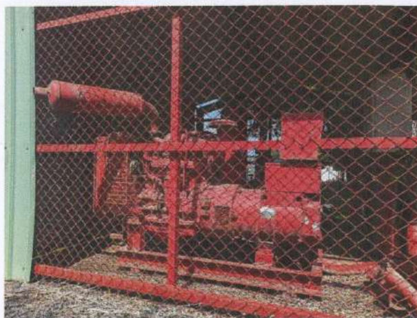
建物現況照(内部)
