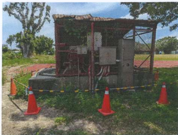
建物現況照(外部)
